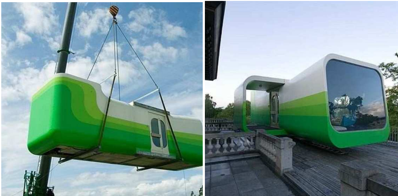
Modulinės erdvės sukurtos iš įrengtų ISO konteinerių bei juos skirtingais būdais jungiančių detalių komplekto (pavyzdžius pateikė UMI atstovė).
